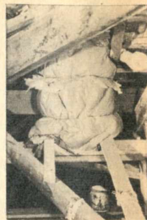
Le ballon bien calorifuge ainsi que la conduite d'arrivée.
